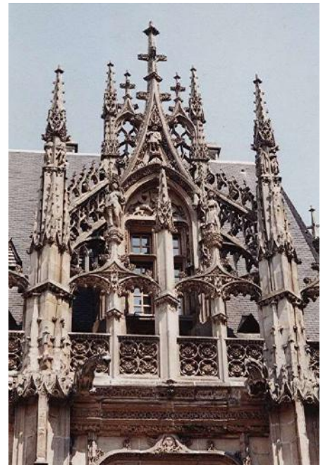
détails : Lucarne, claire-voie et balustrade de style Louis XII se développant à la base du toit du corps central.
